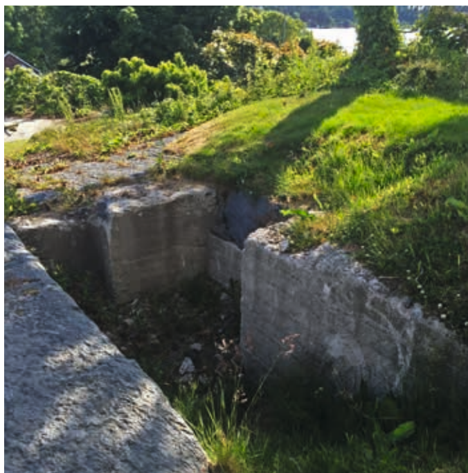
Stilling for stasjonær stridsvogn og rester av løpegrav mot høyre i bildet.
