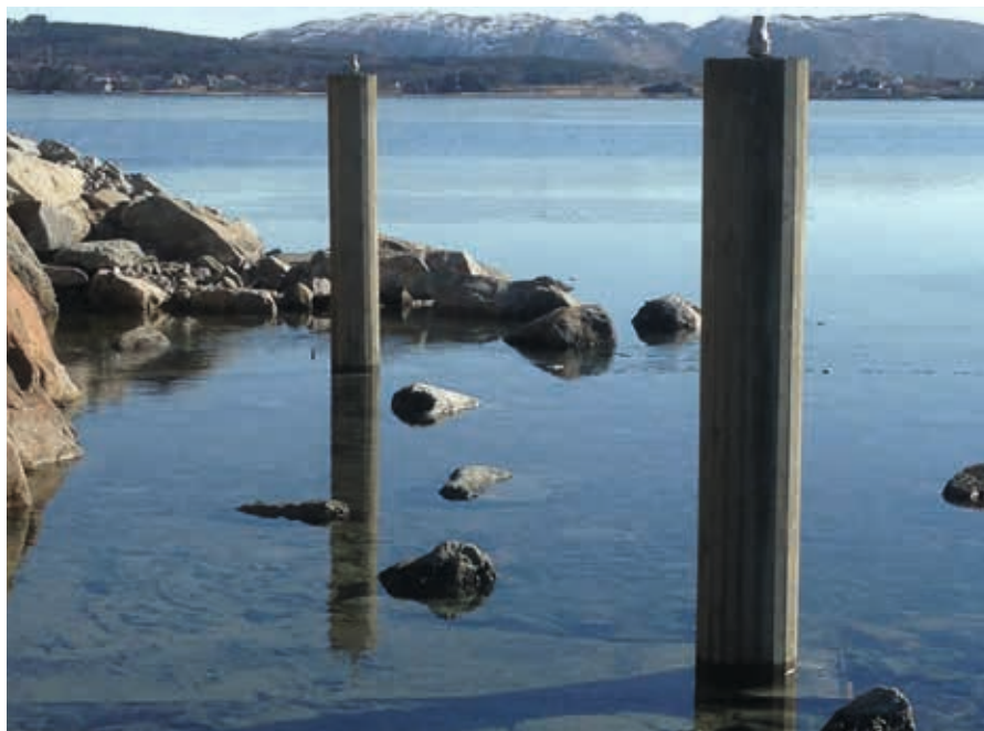
Bropilarene er solid støpt fast under vannflaten. (Foto Maciek).
