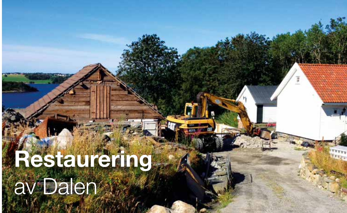
Huset er heist til siden mens grunnmuren bygges.
