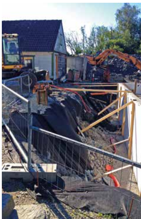
Mye måtte fjernes for å få plass til grunnmuren fordi det gamle huset sto rett på bakken.
